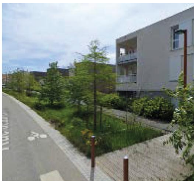
Voie partagée accompagnée d'une noue / Passerelle Rue Jean Giono ZAC Vidailhan, Toulouse (31) - Mutabilis paysage
