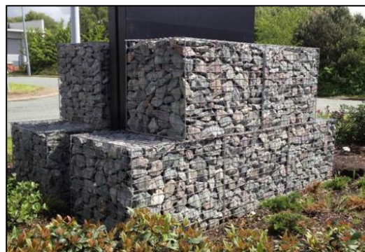
Figure 10 : Exemple de muret en gabion (Source : TCS Geotechnics)
