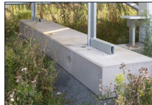
Figure 9 : Types de fondation - semelle béton (Source : Guide MEDDTL 2011 – NCA, 2015)
