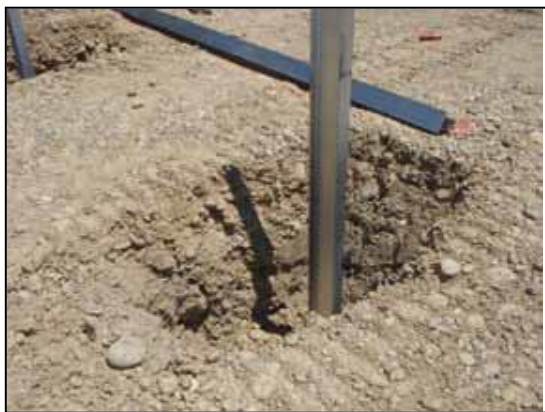
Figure 8 : Types de fondation - pieux battus (Source : Guide MEDDTL 2011 – NCA, 2015)
