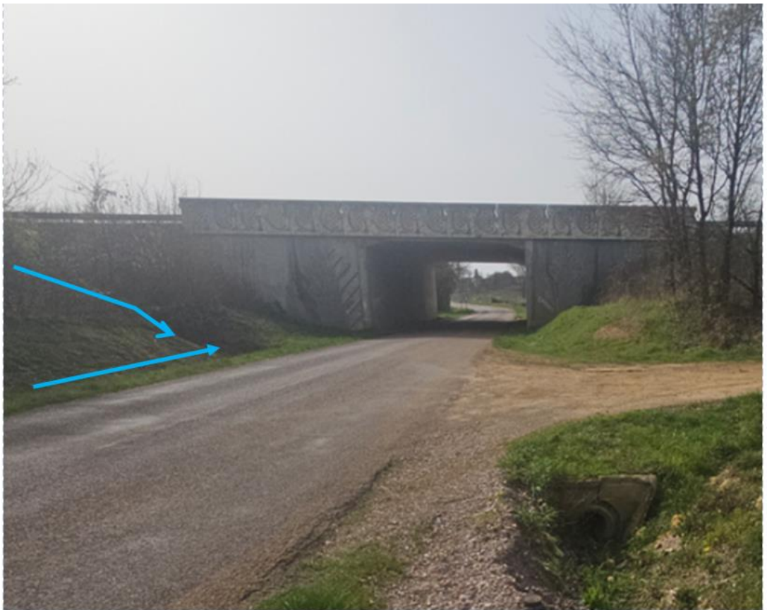
Figure 7 : Photographie de l'exutoire actuel, avec sur la gauche l'emprise projet, les fossés d'accotement de la RD249
