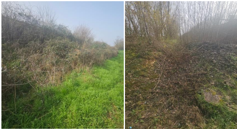
Figure 5 : Fossé le long de l'A72 et exutoire au niveau de la RD249
