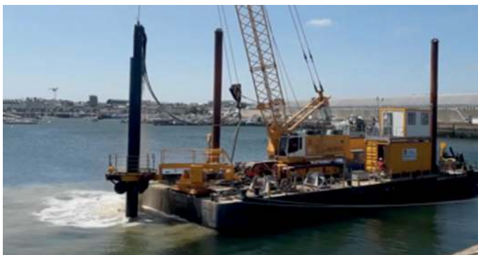
Fig. 24 - Illustration d'un panache de turbidité généré par le battage de pieux (Merceron)
