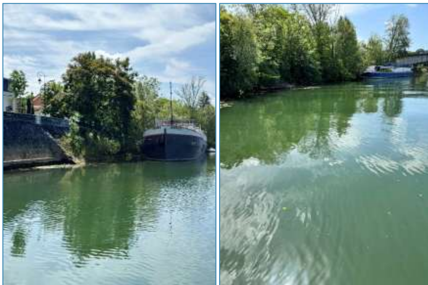
Berge nord entièrement bétonnée, vue d'ensemble de la zone
