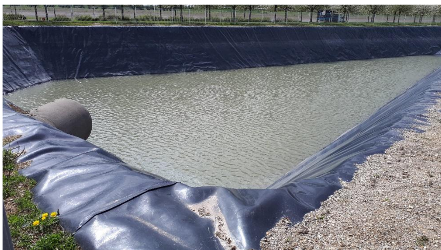
Le bassin de rétention existant, qui permet de gérer les eaux pluviales du site existant
