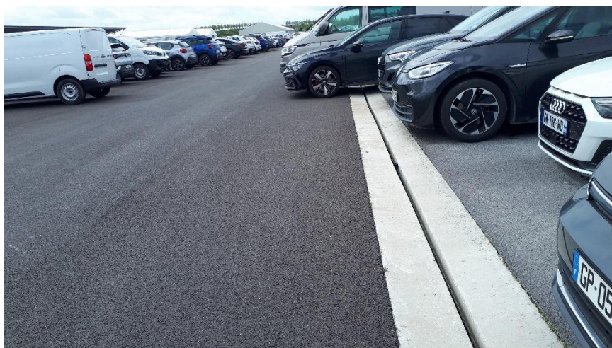
Les satujos, permettant la collecte des eaux pluviales
