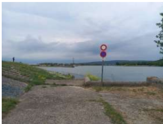
Rampe de mise à l'eau (Source : Améten, avril 2026)
