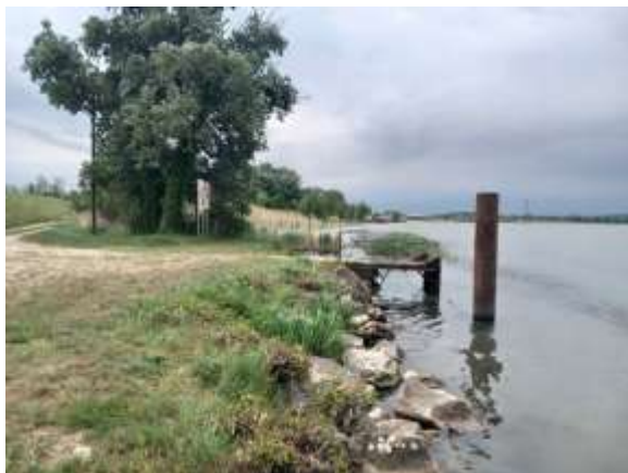
Enrochement, duc d'albe et ponton (Source : Améten, avril 2026)
