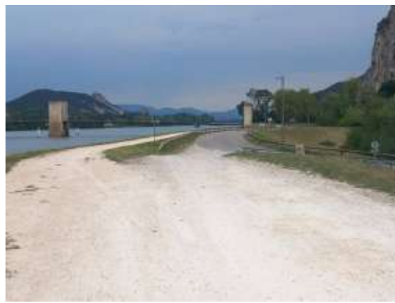
Cheminement piéton, cyclable et route avenue du Rhône
