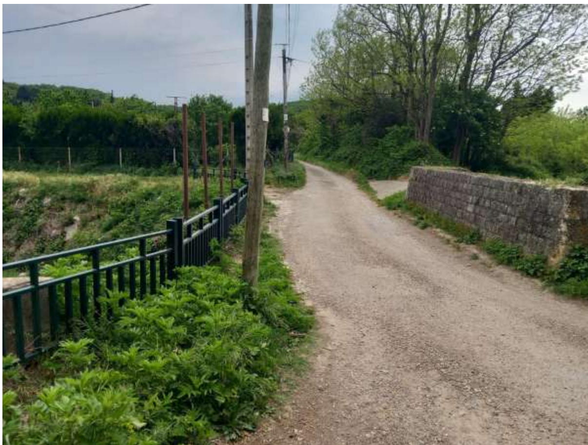
Figure 48 : Passage au-dessus de la zone humide au niveau du chemin des Ribières (Source : Améten)
