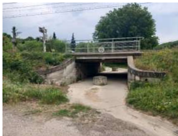
Passage sous voie ferrée
