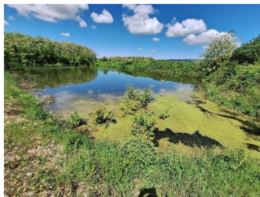
Photographie 8 : bassin d'infiltration avec végétation hygrophile
