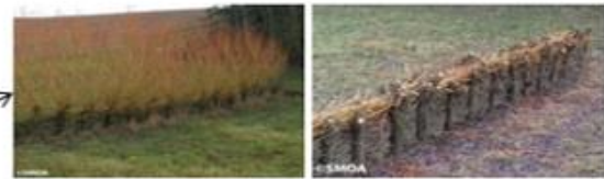
Ex : Fascines mortes ou vivantes (freine l'eau et limite l'érosion sans créer de zone inondable)
