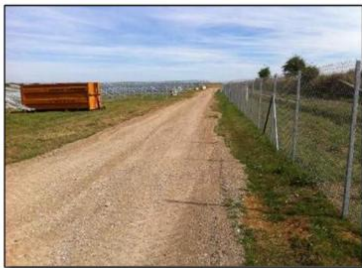
Figure 42: Exemple d'une bande de roulement adaptée aux véhicules lourds
