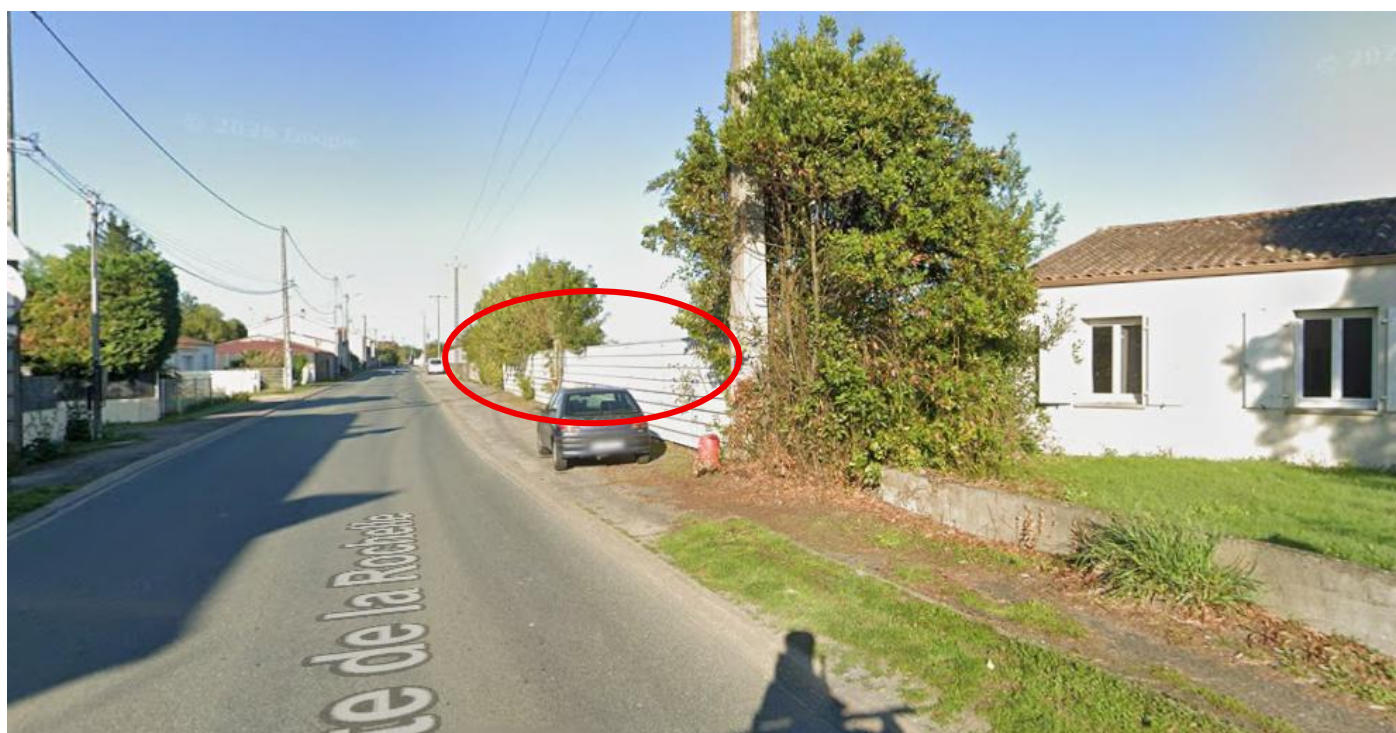
Photographie depuis la RD plus au Sud – Est (n°5) – Google Maps – Septembre 2025
