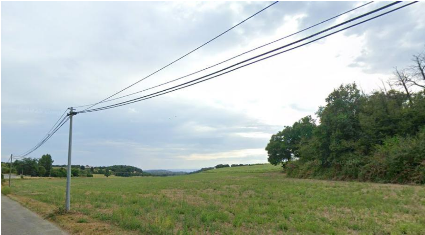
Figure 44 - Prise de vue proche 7 (Source : GoogleStreetView, août 2024)
