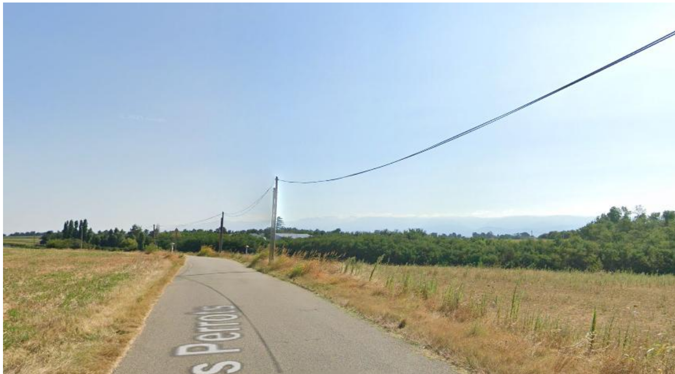
Figure 39 - Prise de vue proche 2 (Source : GoogleStreetView, août 2024)
