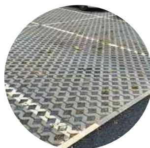
Dalle alvéolaire béton, remplissage en gravier
