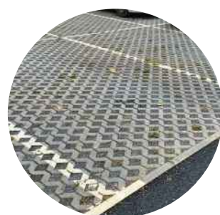
Dalle alvéolaire béton, remplissage en gravier
