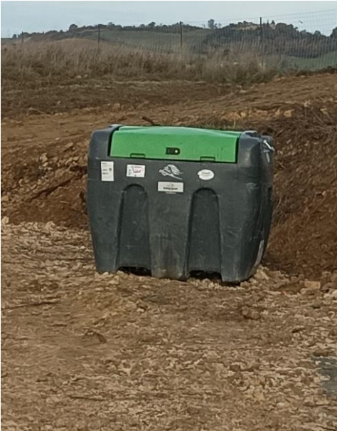
Illustration 7 : Stockage d’hydrocarbures dans un bidon étanche sur bac de rétention (Source : INDDIGO, suivi de chantier)
