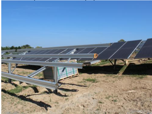
Illustration 3 : Fixation des panneaux solaires sur les tables après alignement final, à gauche (source : INDDIGO) et pose des modules à gauche (Source : EDF power solutions)
