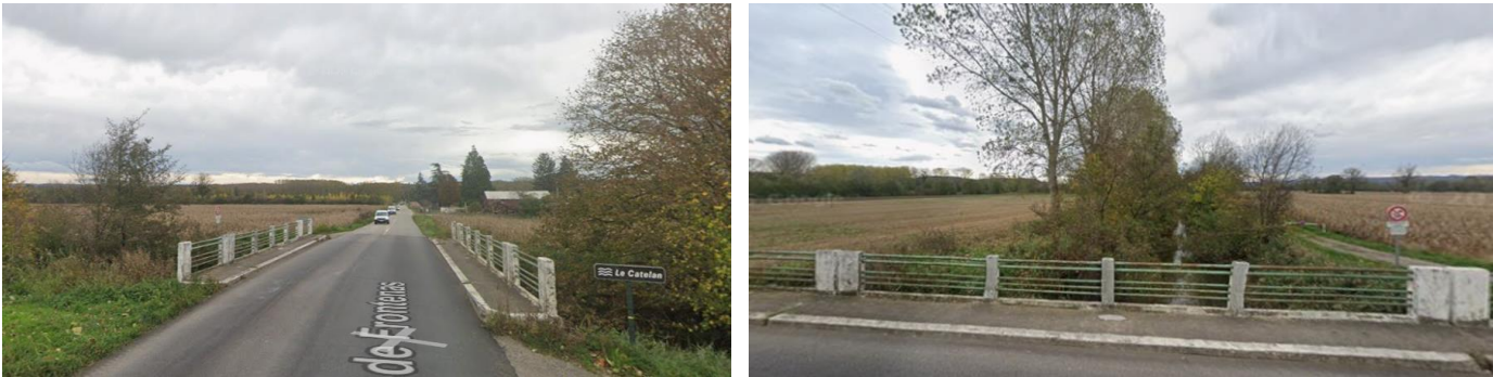
Figure 9 : Vue de l'ouvrage hydraulique au-dessus du Catelan
