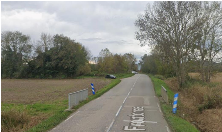
Figure 8 : Vue sur l'ouvrage hydraulique au-dessus de la Vieille Rivière
