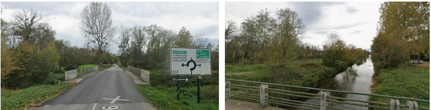
Figure 10 : Vue de l'ouvrage hydraulique au-dessus de la Bourbre
