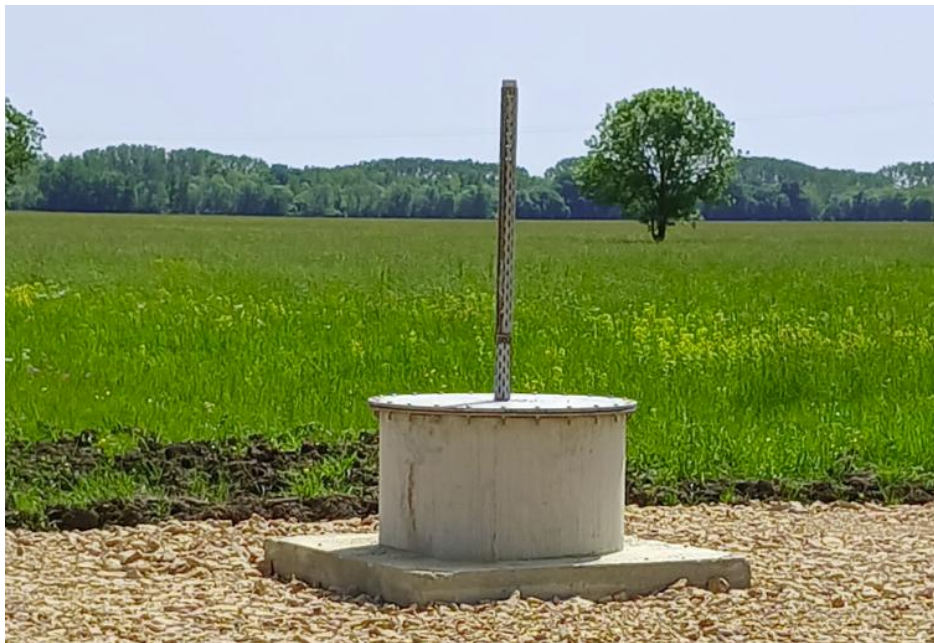
Photographie 6 : Exemple de tête d'ouvrage
