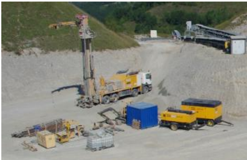
Photographie 3 : Exemple de d'atelier de forage – Foration rotary
