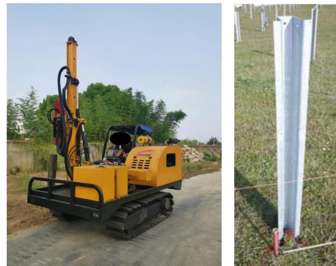
Figure 37 : Type d'engin utilisé pour enfoncer les pieux
