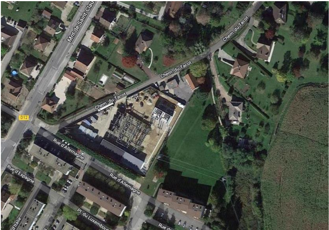
Figure 10: Vue aérienne du poste source
