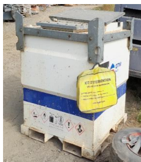
Exemple de kit antipollution présent directement sur la zone de chantier et visible (à gauche) et utilisation d'une feuille absorbante pour absorber une fuite d'huile de moteur (à gauche) (Biotope, 2024)
