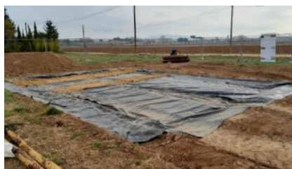
Exemple d'installation d'une bâche pour le stockage d'engin (Biotope, 2022)
