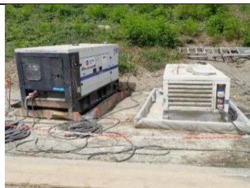
Exemple de groupes électrogènes sur bac de rétention en plastique et en équerre (Biotope, 2024)
