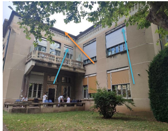
Corniche et coffres des volets roulants du pavillon M
