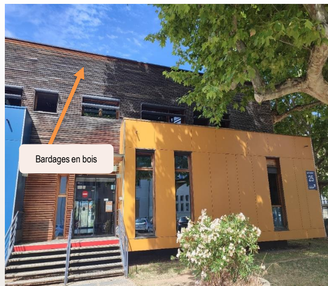
Bardages du bâtiment 25
