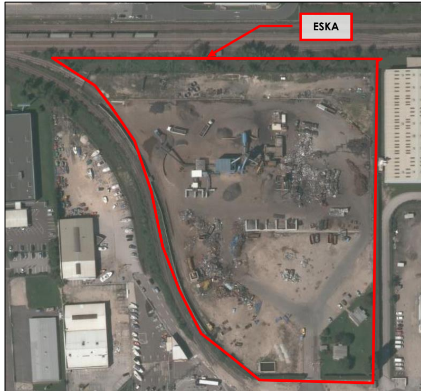
Figure 5 : Vue aérienne des anciennes installations de broyage et des stockages associés
