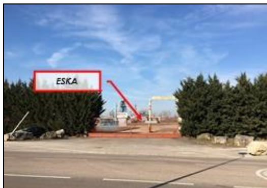
Figure 13 : Visibilité du site en façade Sud (2019)
