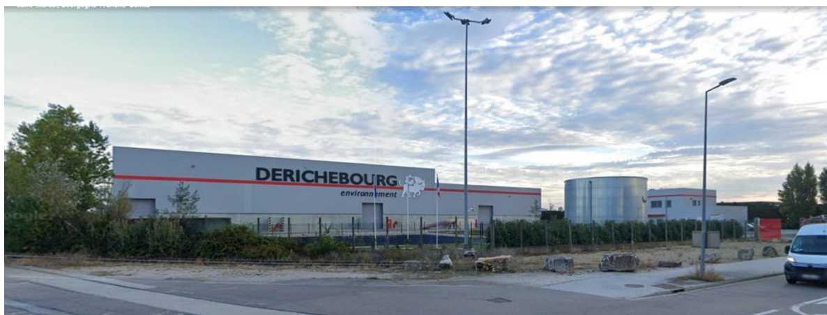
Figure 15: Visibilité actuelle du site en façade Sud
