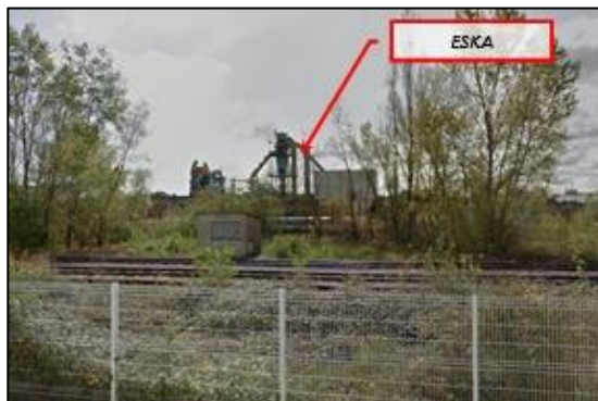
Figure 14 : Visibilité du site en façade Nord (2018)
