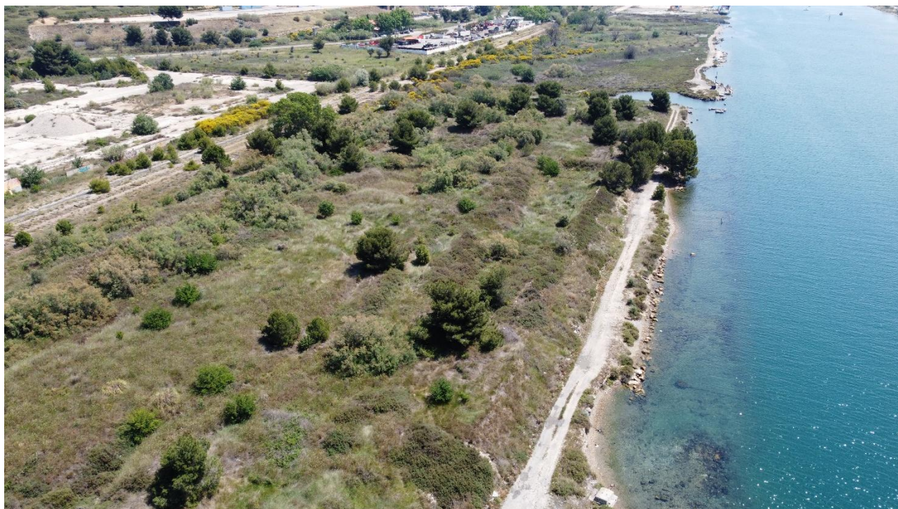
Photo 3 : Vue globale des dépôts existants (végétalisés) sur la moitié Est de la parcelle AE0201
