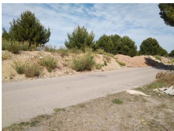
Voie d'accès au site et talus
