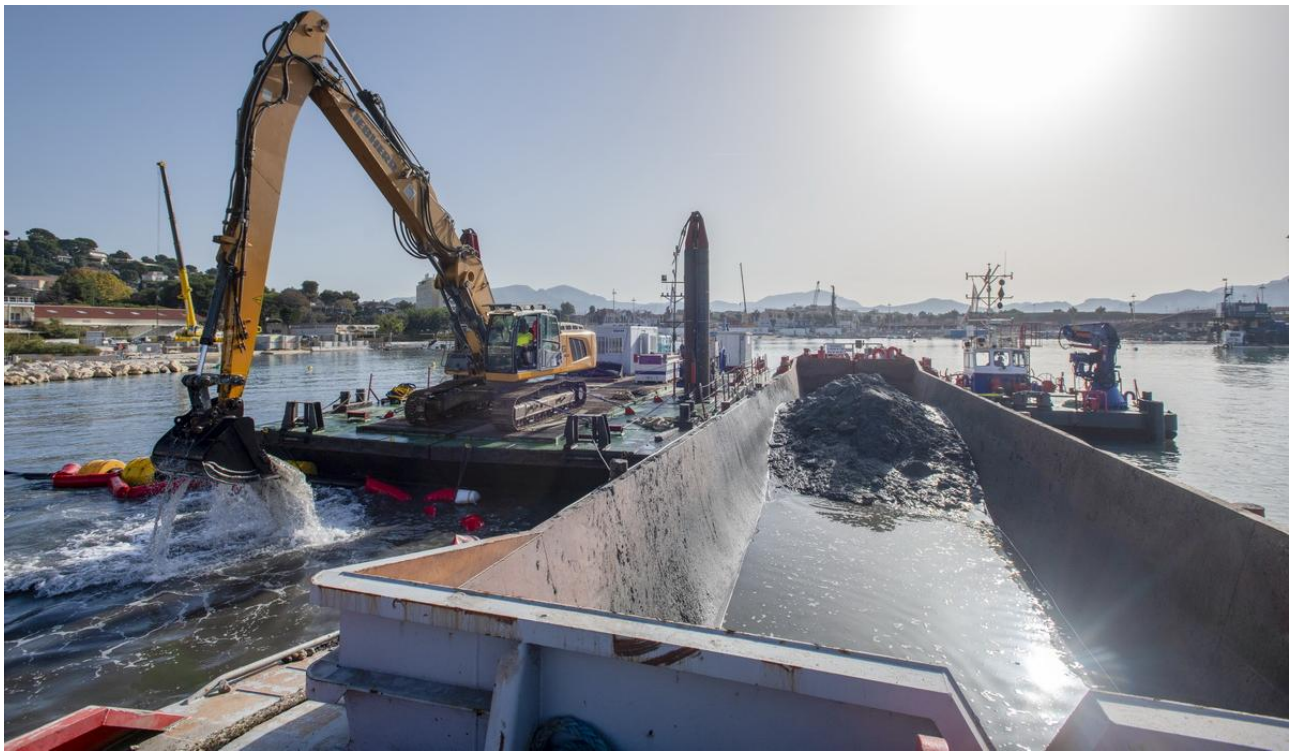
Figure 13 : Illustration d'un atelier ponton-pelle avec chaland (OCÉLIAN, 2024)
