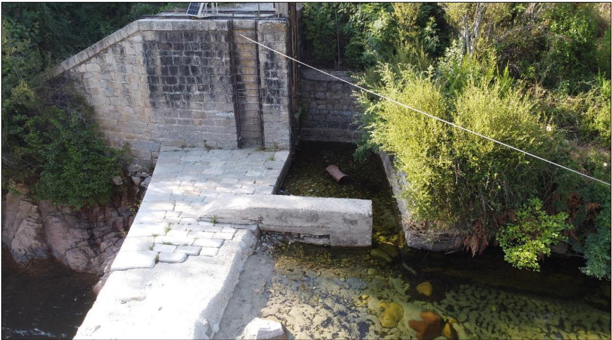
Figure 4 : Vue de la prise d'eau du canal en rive droite
