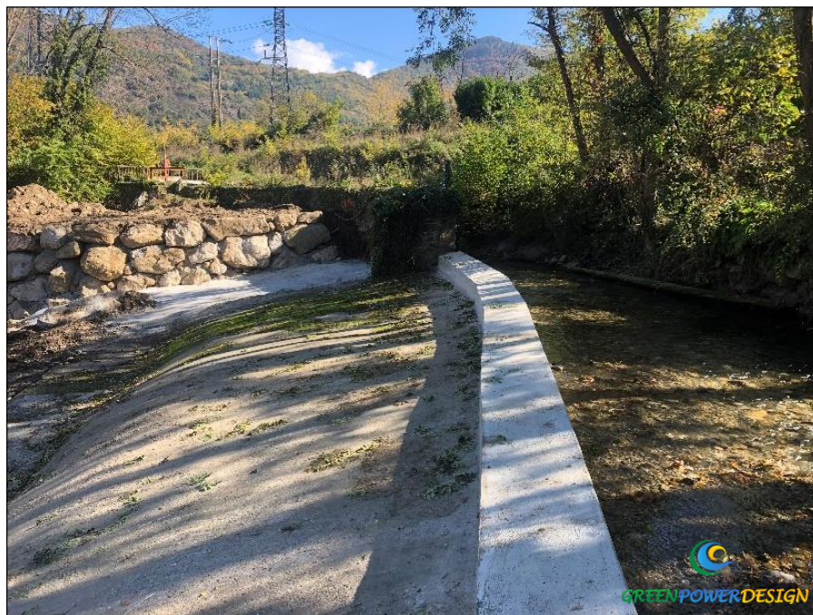
Figure 20 : Vue d'une crête de barrage réalisée avec une longrine en béton armée sur un seuil en pierres existant (Etudes GPDesign)
