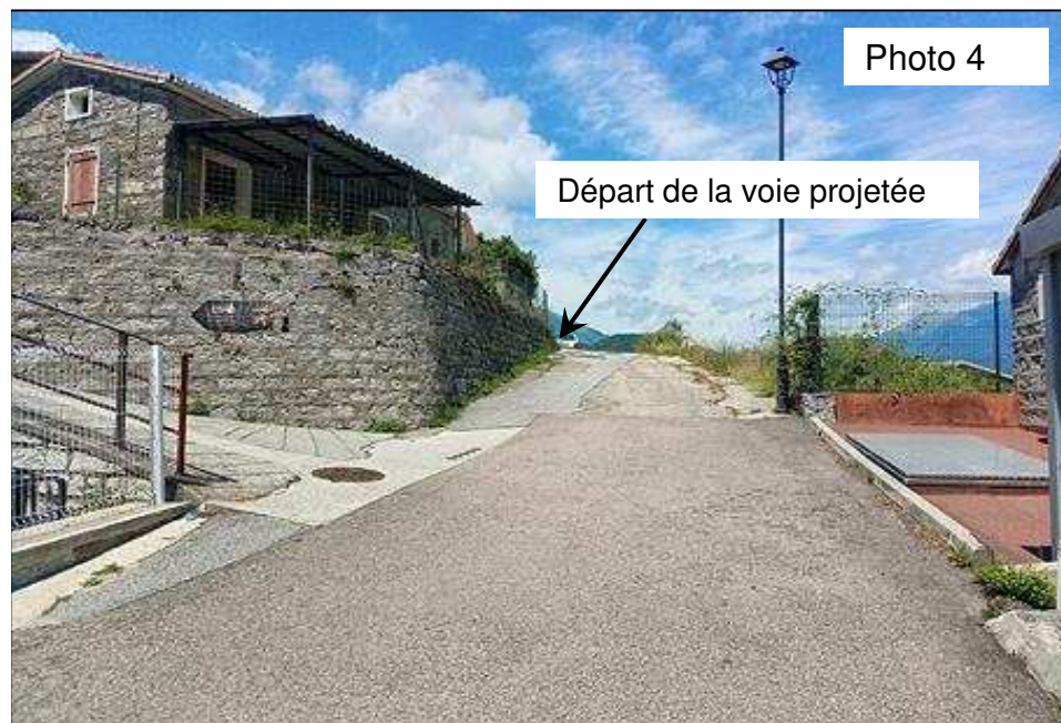
Voirie existante à l'est du bourg dans le prolongement de laquelle le projet s'inscrit.
