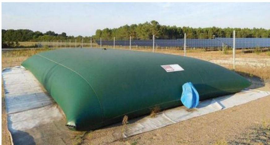
Figure 6 : Exemple de citerne souple autoportante d'eau de défense incendie
