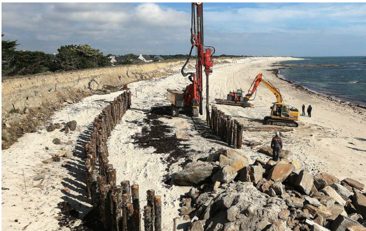
Figure 19 : Mise en place des pieux par vibrofonçage à la plage de Léhan
