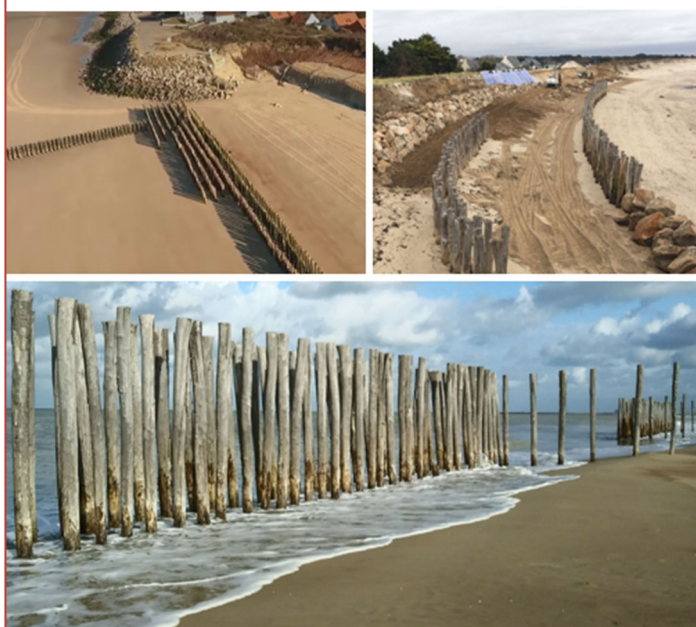
PHOTOGRAPHIE DE PIEUX
