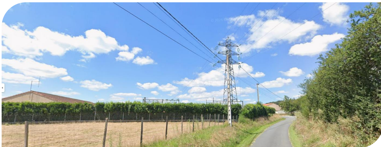
Poste de Réalmont – Source Google Street View
