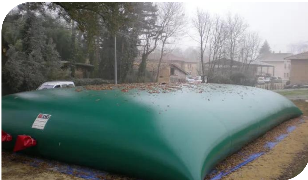
Apparence d'une réserve incendie souple.
