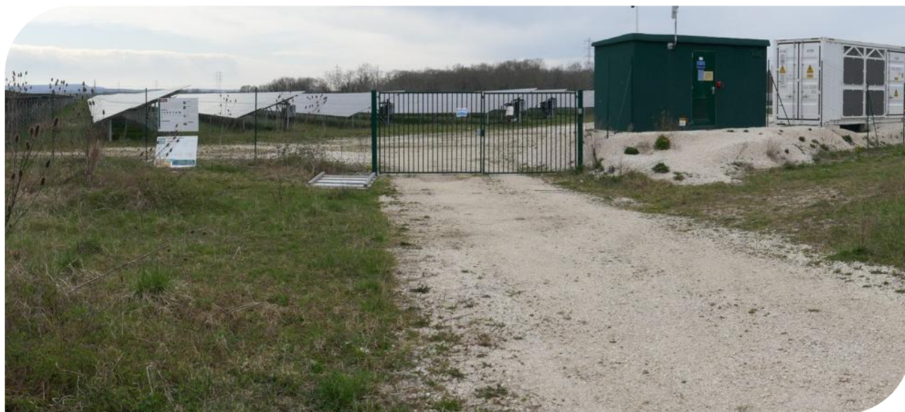
Apparence des clôtures entourant la centrale.
