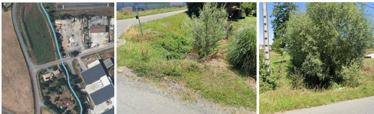
Figure 10 : Passage busé au-dessus du Ruisseau de Blima (Source : Géoportail 2022, Google Street View 2024)
