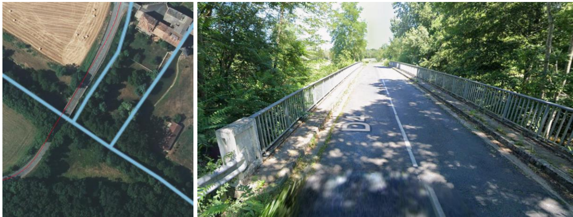
Figure 9 : Passage d'un pont au-dessus du cours d'eau le Dadou (Source : Géoportail 2022, Google Street View 2024)
