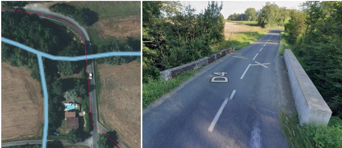
Figure 8 : Passage d'un pont au-dessus du Ruisseau de Miral (Source : Géoportail 2022, Google Street View 2024)
