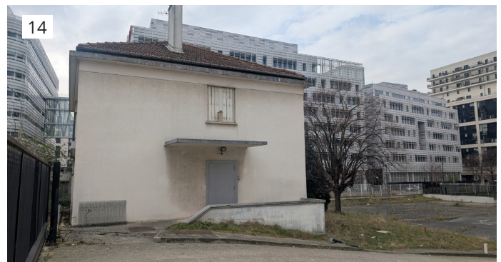
Fig.27 : Vue sur le pavillon présent sur le site (TRANS-FAIRE, 2026)
