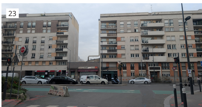
Fig.36 : Vue sur le boulevard Jean Jaurès depuis la rue Adrien Meslier (TRANS-FAIRE, 2026)
