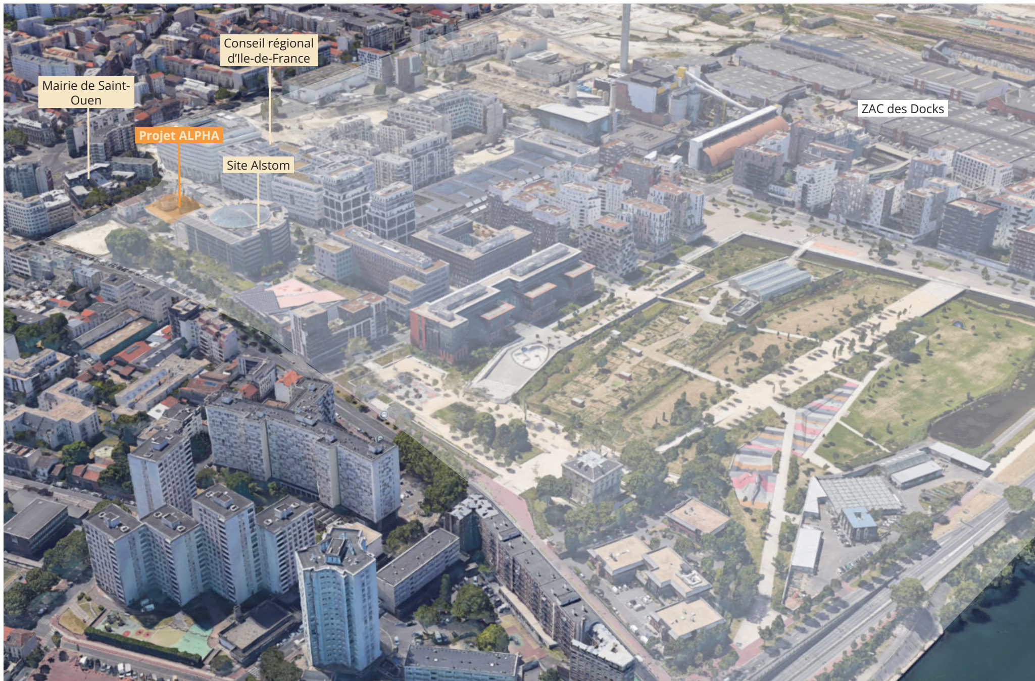
Fig.8 : Vue lointaine depuis le nord du projet (Google Earth, 2026)
