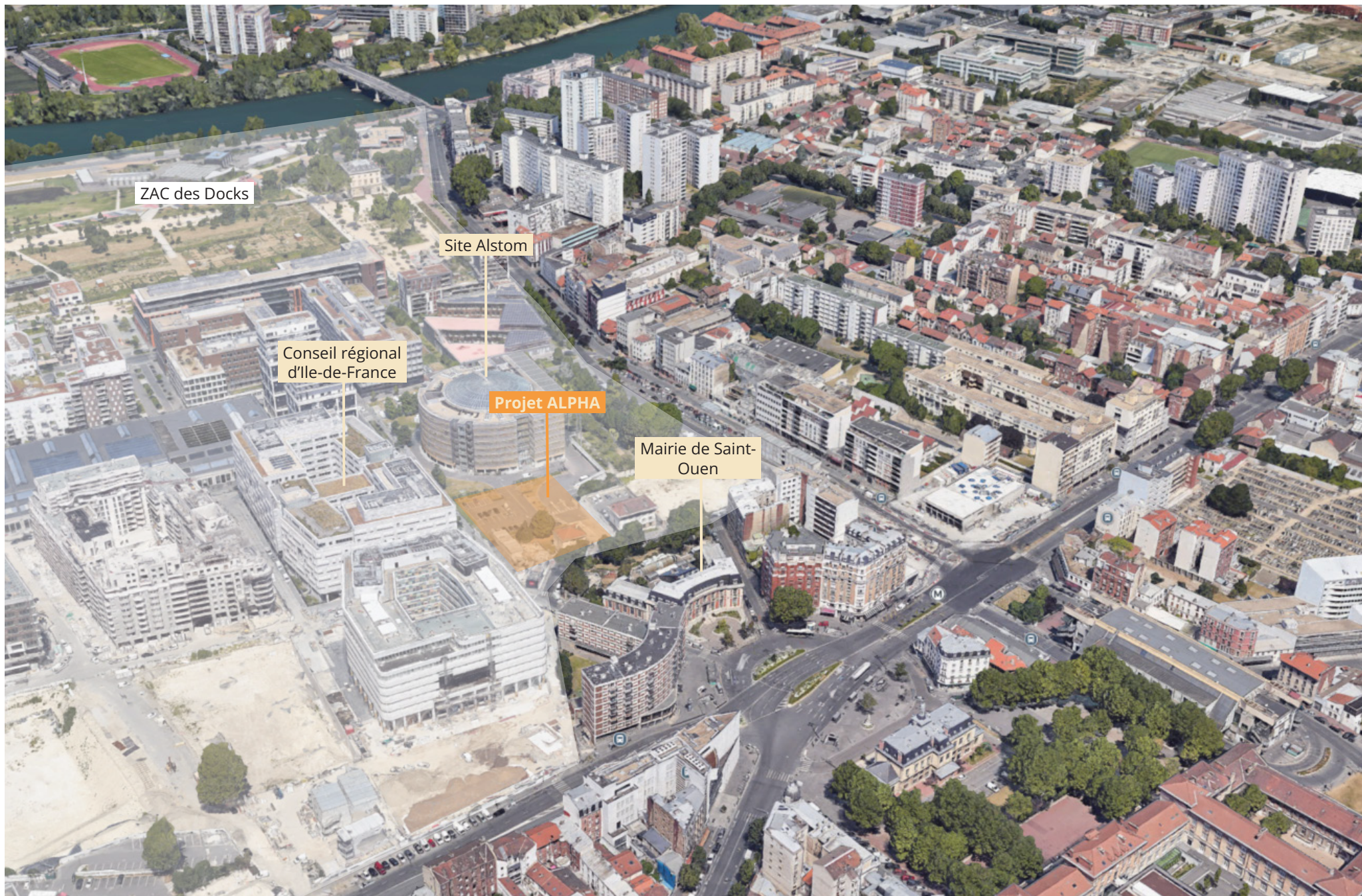
Fig.7 : Vue lointaine depuis le sud du projet (Google Earth, 2026)
