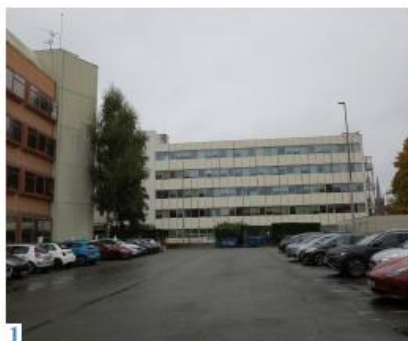
1 Vue du parking / prise le 05.09.2023
