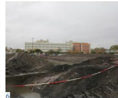
6 Vue depuis la Branche de Croix / prise le 13.11.2023
