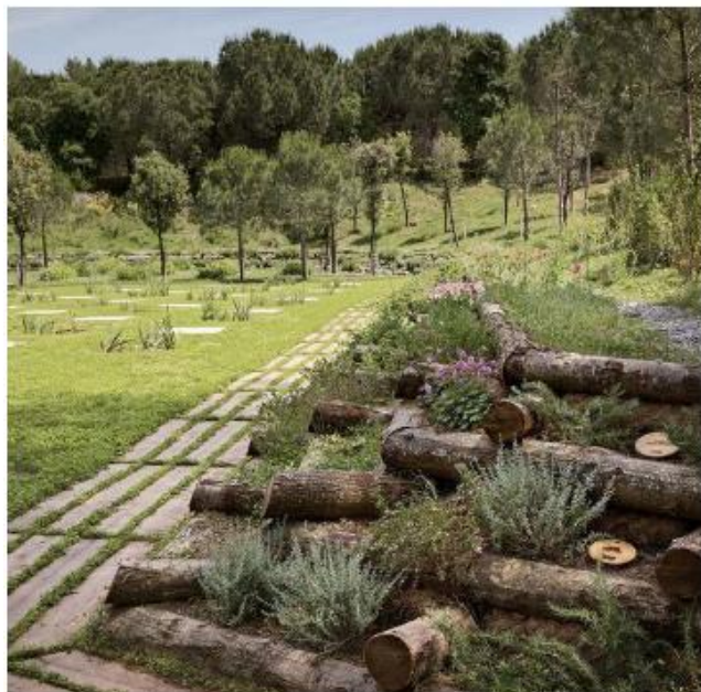
En soutènement de talus
