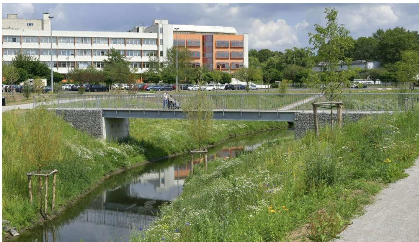
Figure 6 - Renaturation de la Branche de Croix (Source : Ville de Croix)
