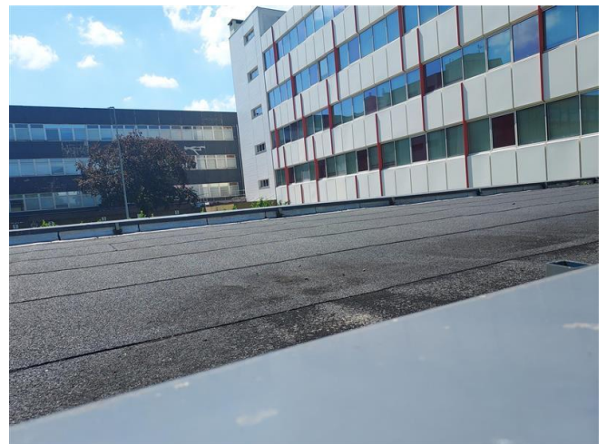
Toiture plane du bâtiment n°4
