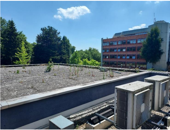
Toiture plane du bâtiment n°3
