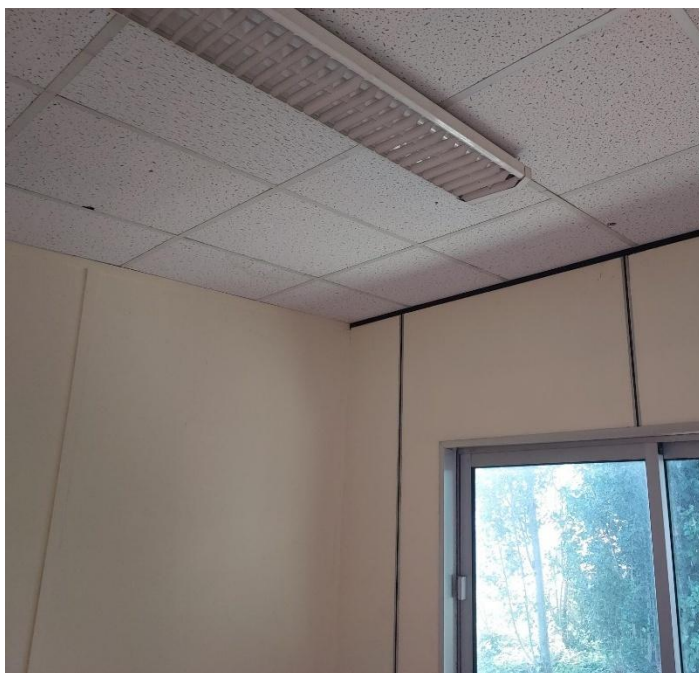
Pièce témoignant de l'architecture interne du bâtiment n°2
