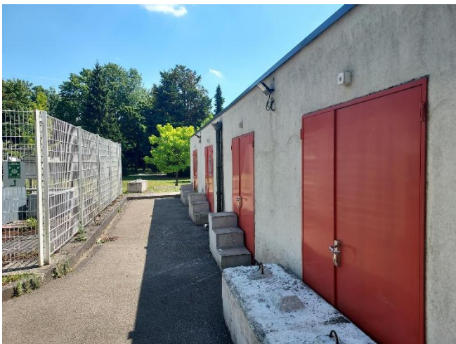
Façade Nord-Est du bâtiment n°4
