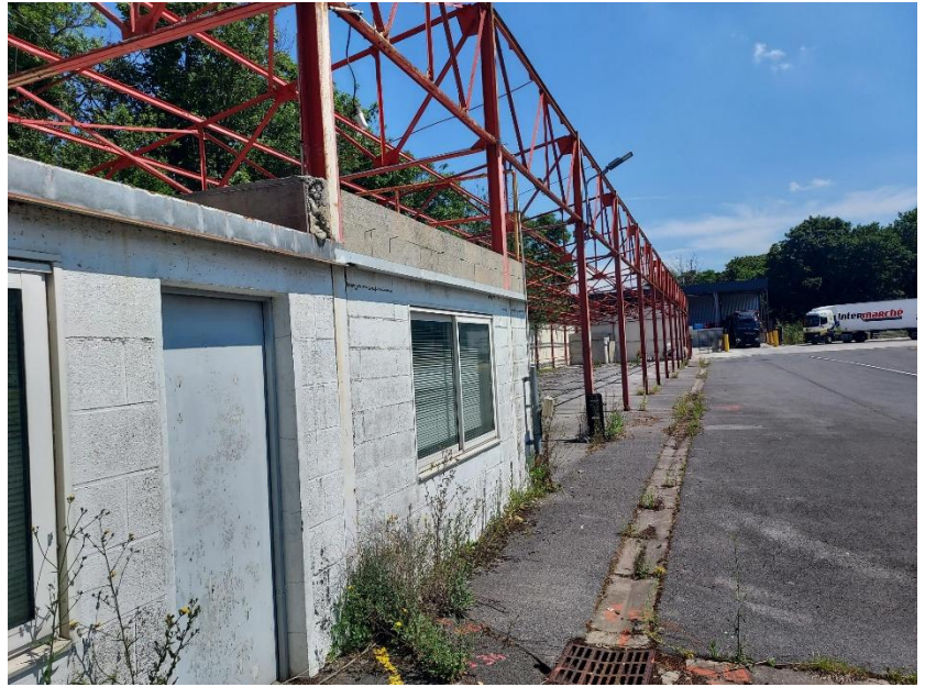
Bâtiment n°6 et l'un des édifices en parpaing
