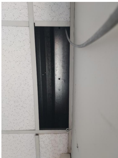
Faux-plafond suspendu du bâtiment n° 2
