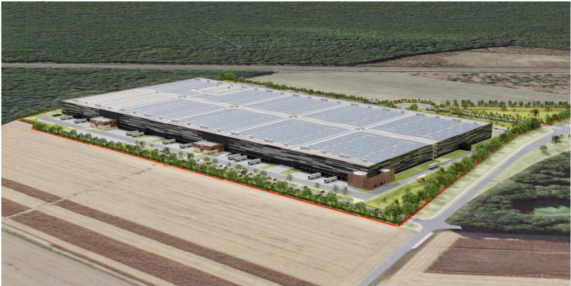
Vue aérienne depuis le Nord-ouest
