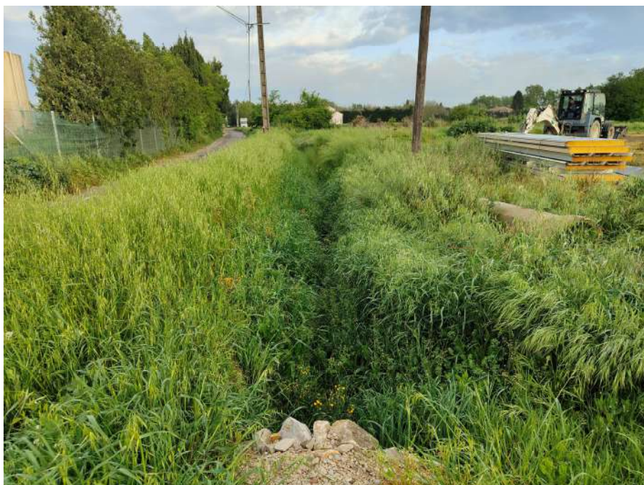
Fossé pluvial existant
