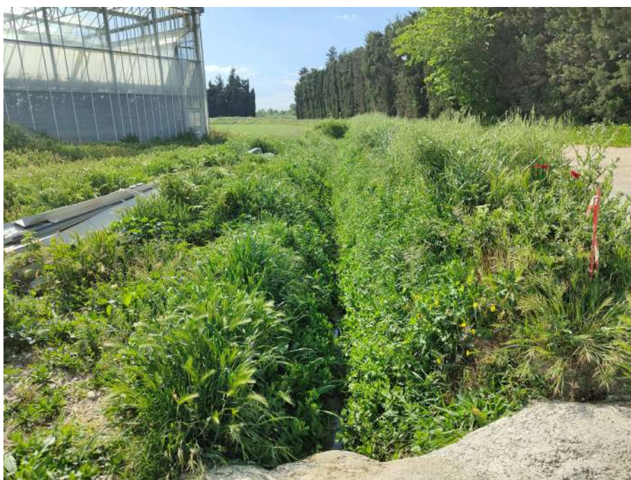
Fossé de collecte des eaux de la serre existante
