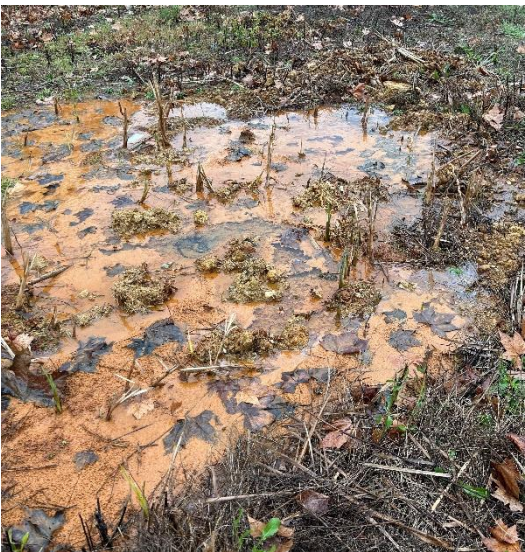
J5.43 - Mare issue d'une fuite souterraine
