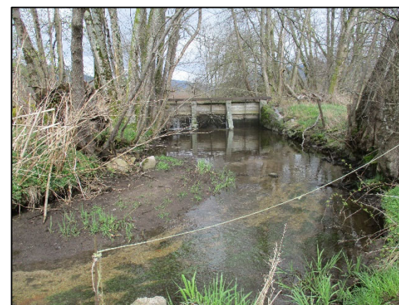
Photo 4 : Vue du vannage depuis l'aval – 13/04/2023
