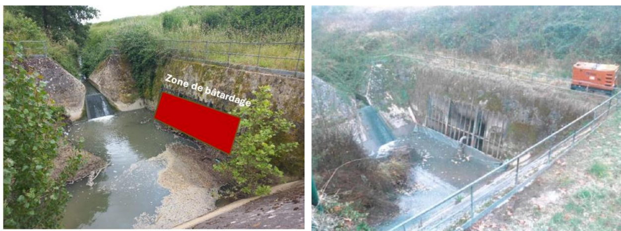
Figure 14 : Zone prévue pour le batardage (à gauche) - exemple lors des travaux de 2016 (à droite)
