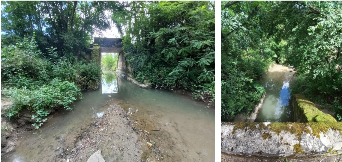
Figure 6 – Ruisseau de la Saudèze à l'amont immédiat du pont de Camparole
