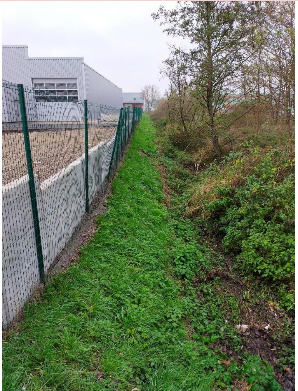
Photographie du fossé
