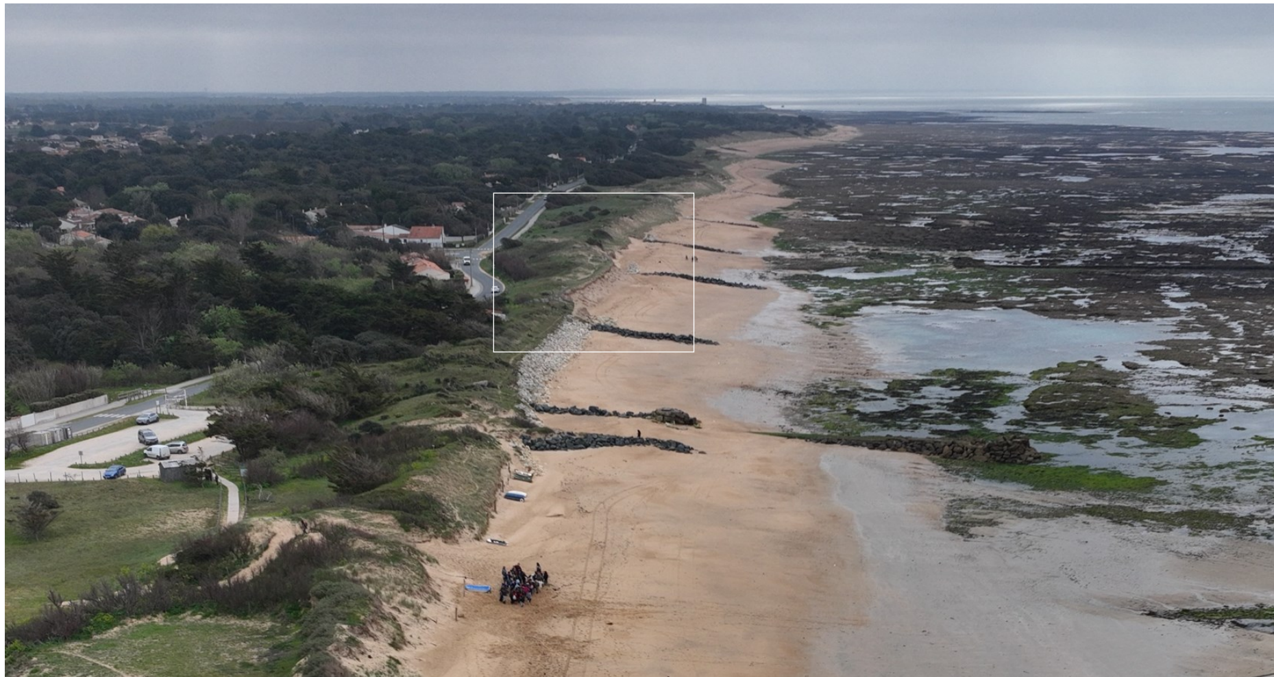
Vue drone, avril 2026 :
