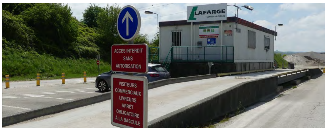
Photo du pont bascule et du poste de garde sur le site des installations
