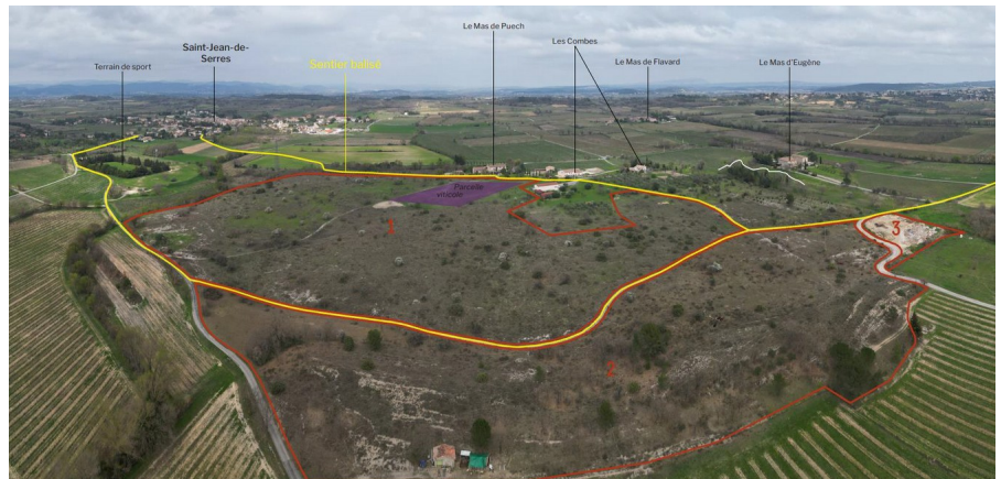
Figure n° 6 : vue drone de la zone d'implantation
