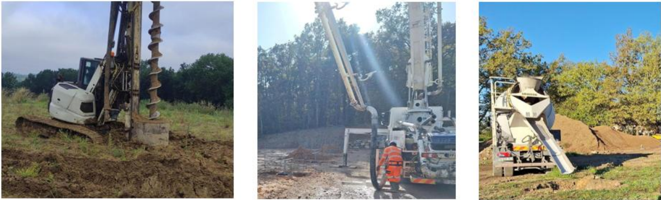
Figure 17 : Exemple d'engins qui seront utilisés pour les fondations.
