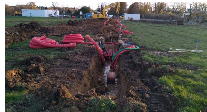
Figure 14 : Exemple de travaux de création d'une tranchée
