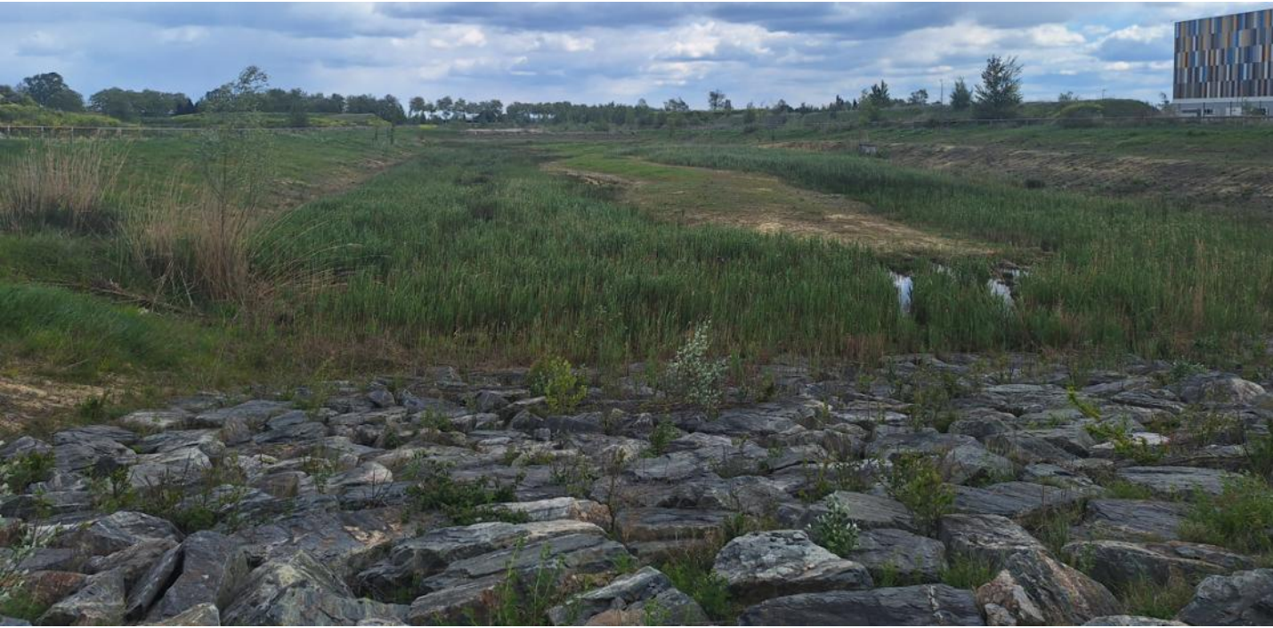
Figure 4 : Etat actuel des bassins de rétention
