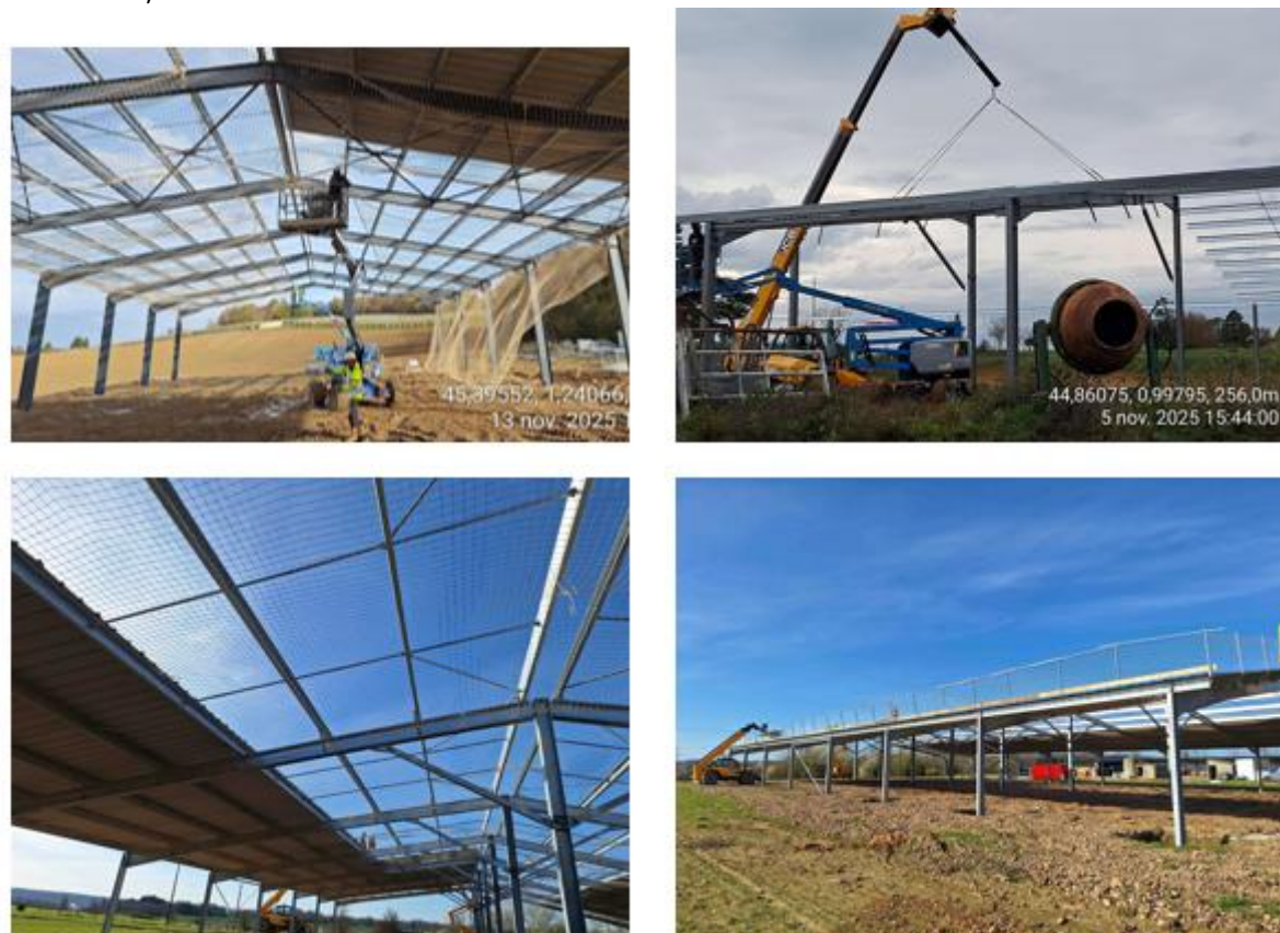
Figure 18 : Exemple d'engins de montage et mise en place de sécurité pour le montage de la charpente et des modules photovoltaïques
