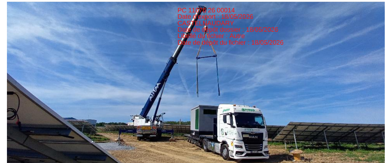
Figure 19 : Installation d'un local technique
