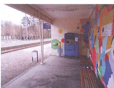
Abri avec billetterie sur quai direction Dijon
