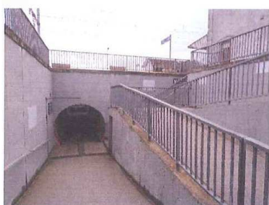
Tunnel d'accès au quai
