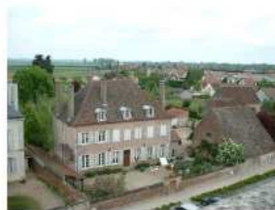
Vues sur la bâtisse Nolet
