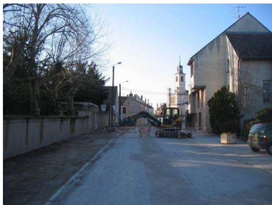
Vues sur la rue Maréchal de Lattre
