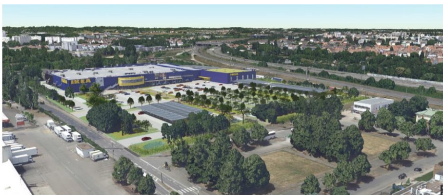
Figure 3 : Vue modélisée du projet d'extension IKEA Strasbourg depuis le Sud-Ouest ; Urbanetic ; mai 2024
