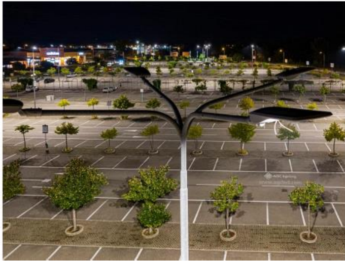
Figure 22 : Type d'éclairage LED envisagé
