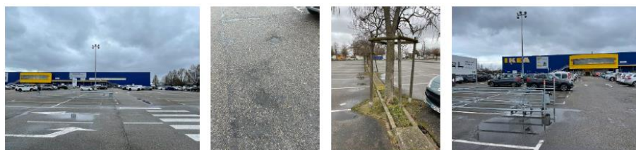
Figure 15 : Photos de l'état actuel du parking, Annexe 9, Note VRD, DNA
