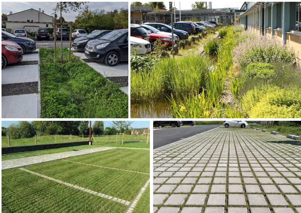
Figure 14. Exemples de noues et techniques de désimperméabilisation
