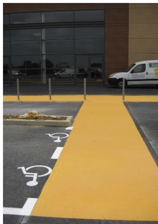
Figure 10. Revêtement résine clair.
