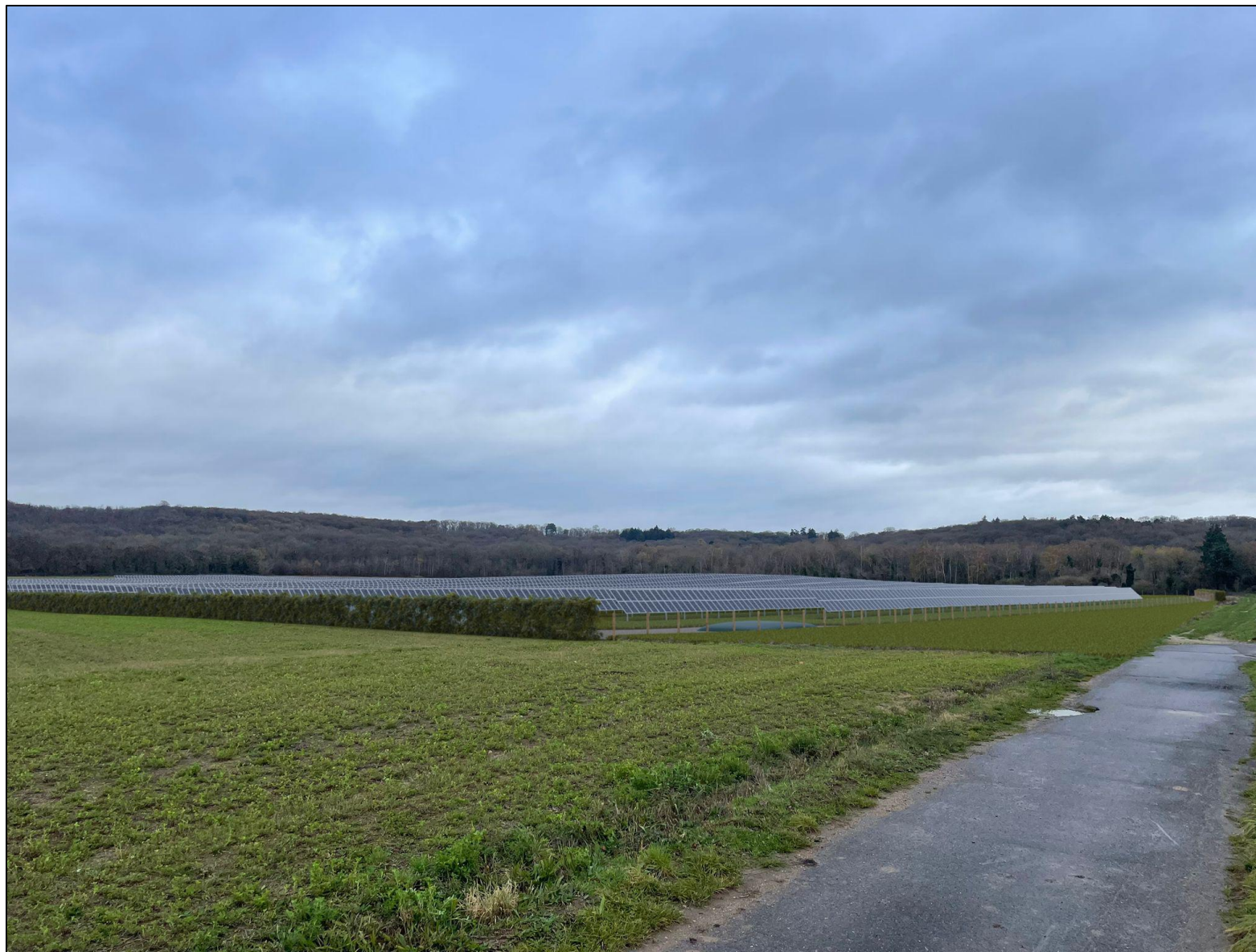
1 – Vu en direction du sud, depuis le nord-ouest de la ZIP (OKA, 2026)
