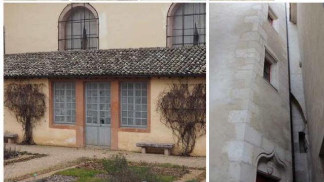
Enduit en surépaisseur, chanfrein, enduit en "sous-épaisseur" : problèmes de mise en œuvre ?
