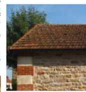
Couverture en tuile mécanique
