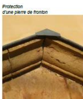
Protection d'une pierre de fronton
