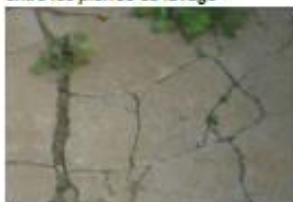
Problèmes d'étanchéité au fond du bassin ou entre les pierres de lavage
