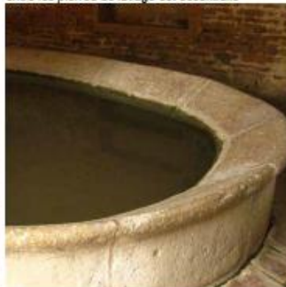
Une bonne étanchéité entre les pierres de lavage est essentielle
