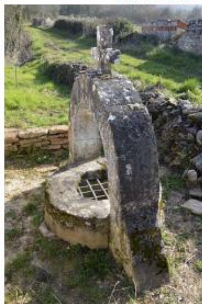
Une grille de protection horizontale est obligatoire sur les puits lorsque la margelle est inférieure à un mètre de hauteur.
