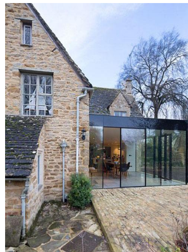
Toiture terrasse sur volume annexe (hors territoire)
