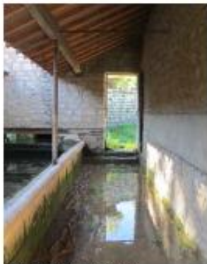
Problèmes d'étanchéité au fond du bassin ou entre les pierres de lavage
