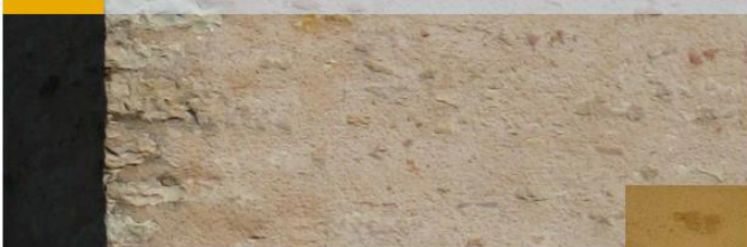
Enduit en surépaisseur, chanfrein, enduit en "sous-épaisseur" : problèmes de mise en œuvre ?
