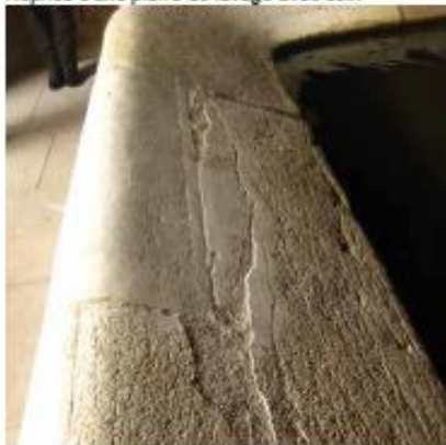
Reprise d'une pierre de lavage avec soin
