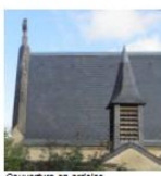
Couverture en ardoise
