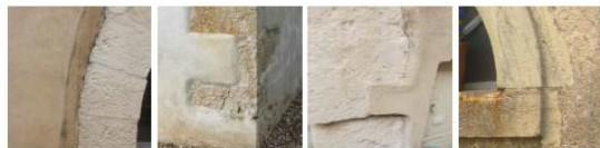
Enduit en surépaisseur, chanfrein, enduit en "sous-épaisseur" : problèmes de mise en œuvre ?
